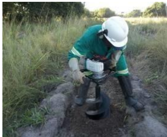
Figura 56: Abertura de cova semi- mecanizada
